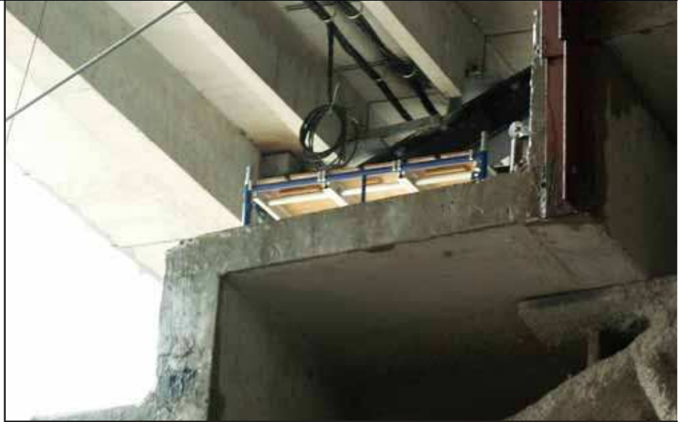
Belden YR46889 扬声器电缆被用于体育场扩音系统中，为扬声器提供最佳音质以及声音完整性。电缆通过带有J型钩的双孔带固定在基础设施上。
